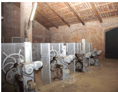
Fig. 10 – Interno dell'edificio con la copertura a capriate lignee e i meccanismi di comando delle paratie
