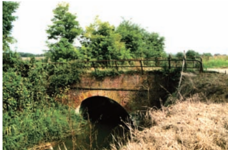
Fig. 6 – Ponte stradale presso Cassine della strada Fossa
