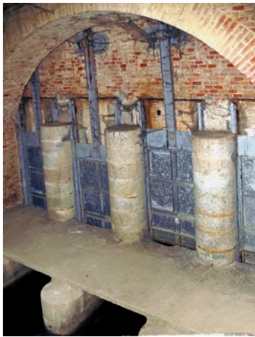
Fig. 9 – Chiavica di Cassine, la chiusa vista all'interno dell'imbocco con le paratie
