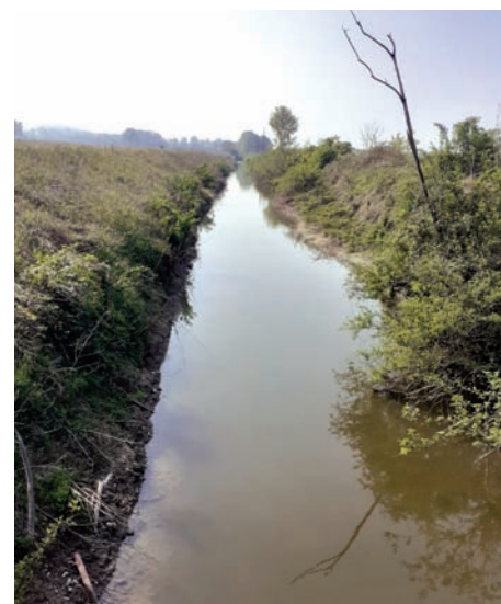
Fig. 2 – Veduta attuale del Canale a Cassine, località Fossa
