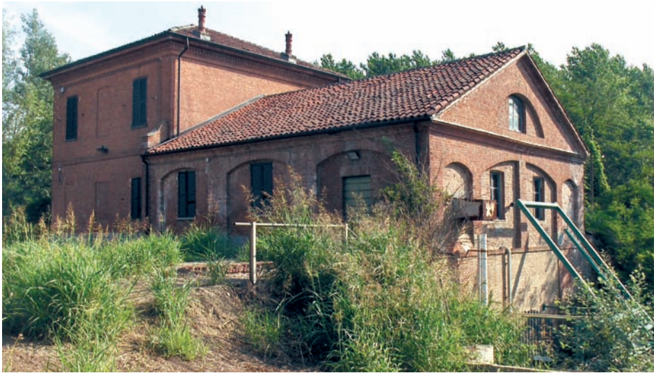
Fig. 8 – Chiavica di Cassine, vista dall'imbocco verso il Bormida
