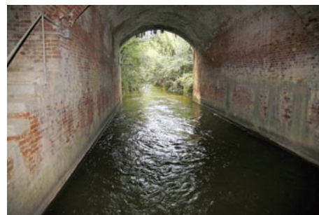
Fig. 11 – Voltone a galleria dell'imbocco che funge da sostegno per gli edifici e spazio di pertinenza esterna
